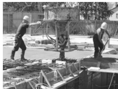
Заливка VST-перекрытия бетоном
